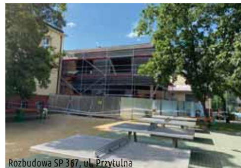
Rozbudowa SP 367, ul. Przytulna
